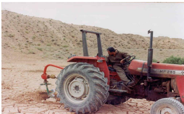
شکل ۲: نحوه استفاده از تراکتور مجهز به مته چال‌کن برای شکستن لایه‌های خشک سطحی [۱۴]
