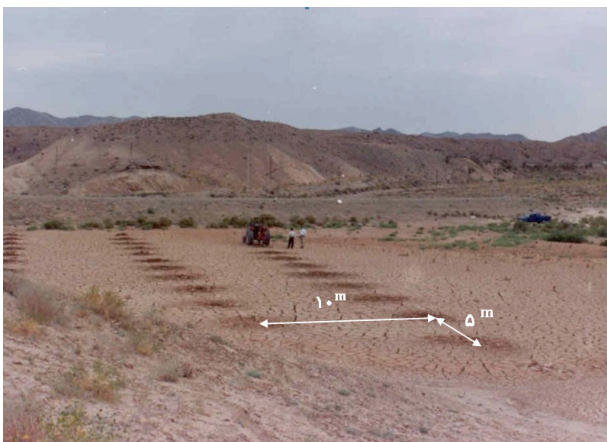
شکل ۱: الگوی حفر چاله‌ها در مخزن بند با تراکتور [۱۴]
