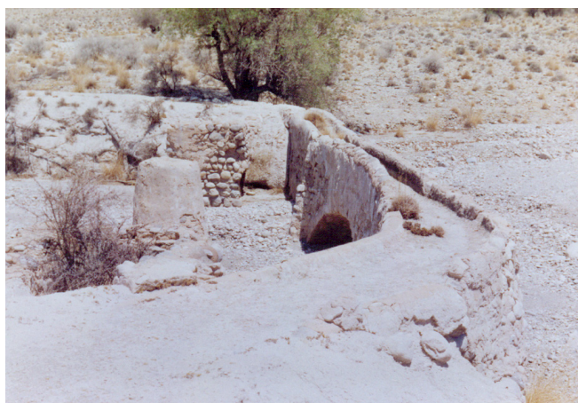
شکل (۲): آبنیه قدیمی جهت عبور آب قنات از عرض آبراهه‌های فصلی
