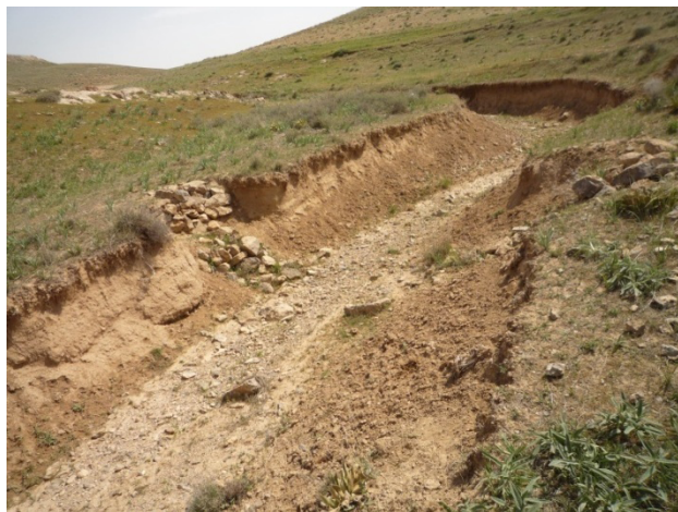
شکل ۶- انتخاب نامناسب محل و نوع بند که سبب تخریب کامل بند گردیده است.
