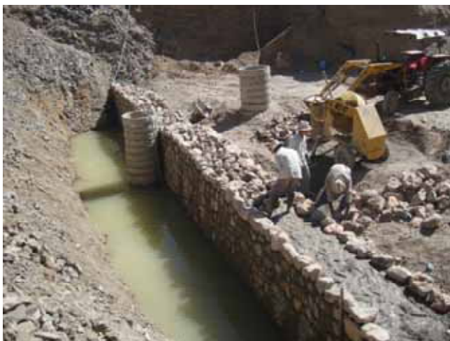
ج: نمایی از احداث سد زیرزمینی در منطقه مورد مطالعه
