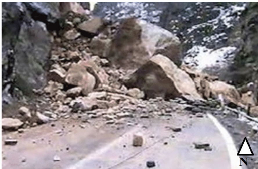
شکل ۳: ریزش کوه در جاده هراز در دامنه جنوبی دماوند [۲۷]
