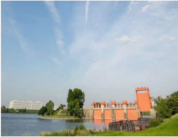
شکل ۸: دروازه‌های آب با موتورهای هیدرولیک
