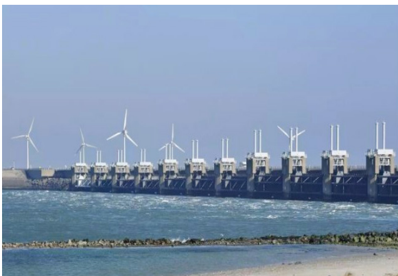
شکل ۹: سد با دروازه‌های متحرک
