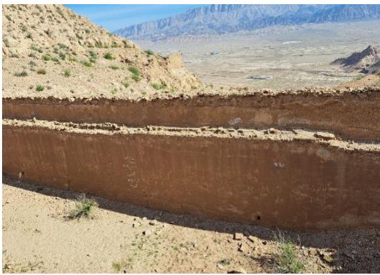
شکل ۱۲: نمایی از دیواره سازه ذخیره آب قلعه دختر
