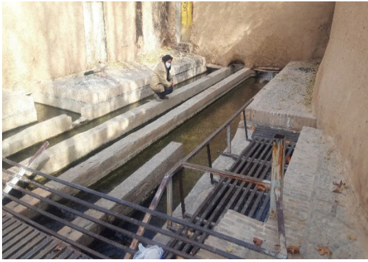
شکل ۱۸: کانال انتقال آب از قنات گوهر ریز معروف به شش مقسم
