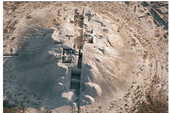
شکل ۱۶: نمای کلی از مخازن ذخیره آب در تپه صوغان
