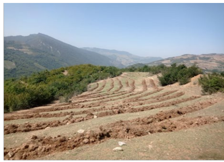
شکل ۱۰: مدیریت رواناب شامل بانکت بندی و احداث هلالی آبگیر در حوزه آبخیز اوغان
