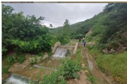
شکل ۱۱: مکان‌یابی و احداث سازه سنگی ملاتی گیر و گابیون در حوزه آبخیز اوغان
