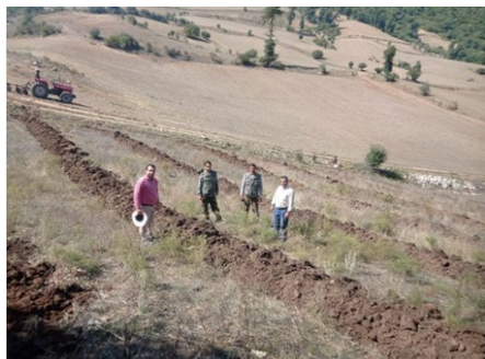
شکل ۱۰: مدیریت رواناب شامل بانکت بندی و احداث هلالی آبگیر در حوزه آبخیز اوغان
