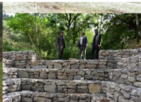
شکل ۱۱: مکان‌یابی و احداث سازه سنگی ملاتی گیر و گابیون در حوزه آبخیز اوغان
